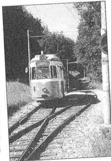
Rationalisierung des Betriebes mittels Rückfallweichen
